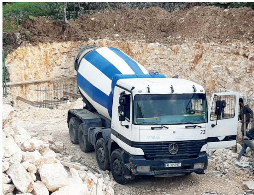
Liban : coulage de la dalle du futur local technique
